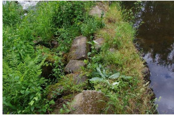
Fig. 18 – Effondrements partiels du seuil
