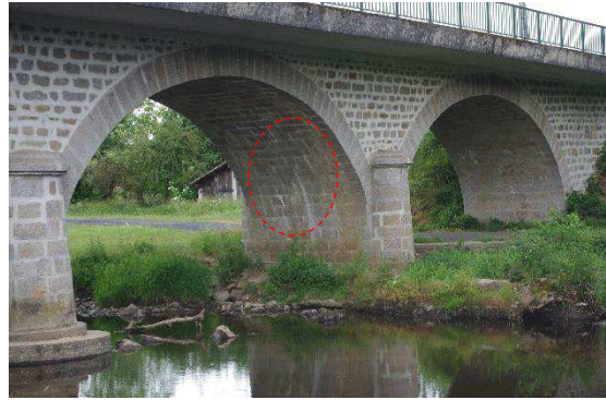
Fig. 10 – Efflorescences de calcite en intrados
