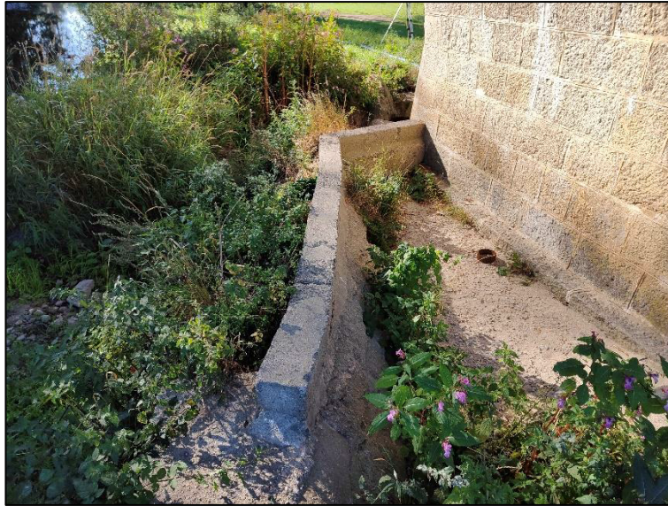
Fig. 34 – Photographie actuelle du niveau du seuil repris en maçonnerie
