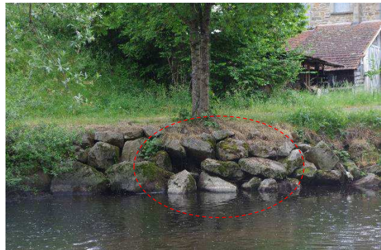
Fig. 20 – Affouillements sur ouvrage aval
