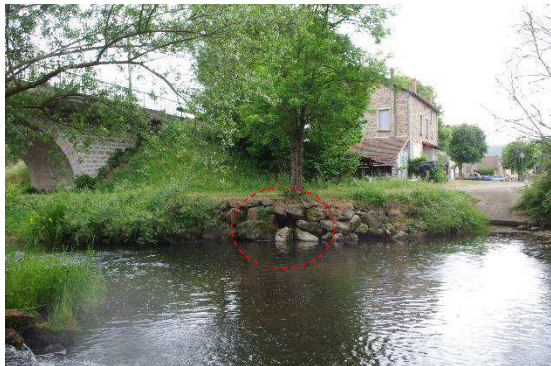
Fig. 19 – Affouillements sur ouvrage aval
