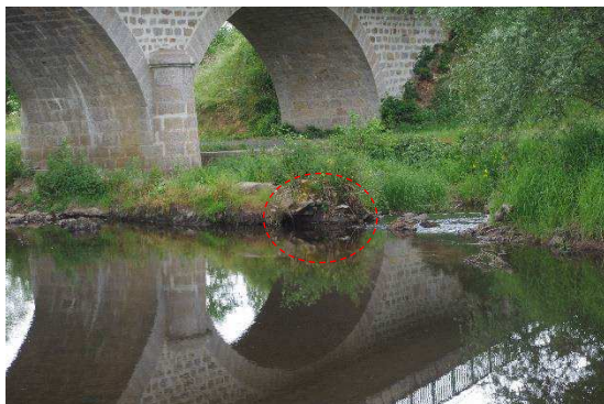
Fig. 13 – Affouillements - seuil
