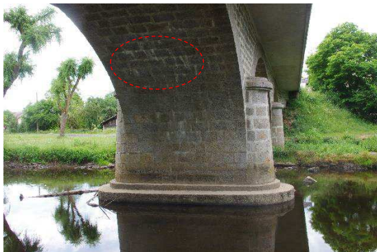
Fig. 11 – Efflorescences de calcite en intrados
