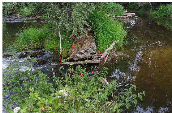
Fig. 14 – Affouillements - seuil
