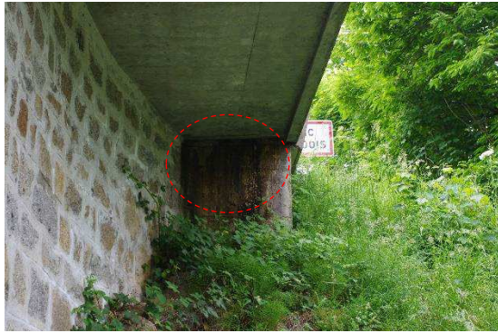
Fig. 9 – Traces d'infiltrations d'eau
